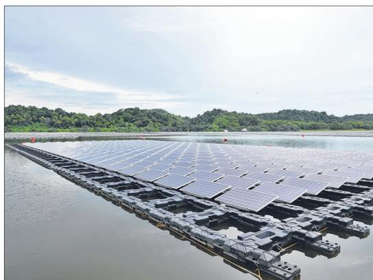
政府计划到2030年将太阳能装机容量推高至2兆峰瓦，相当于我国到时总电力需求的4%。设在登格蓄水池的胜利登格浮动太阳能厂是全球最大的内陆浮动太阳能光伏系统之一，每年可生产60兆峰瓦电力。(谢智扬摄)
